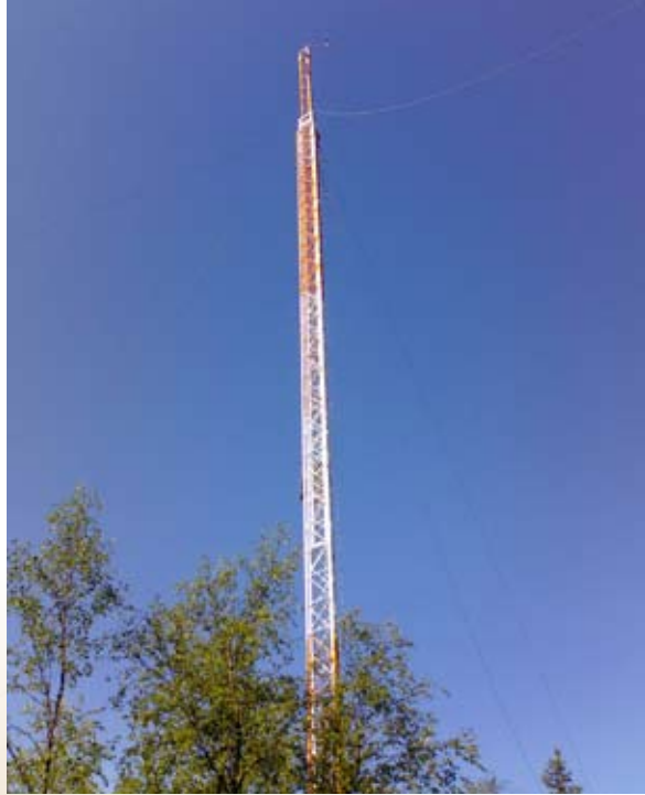
Tuulimittausmaston pystytys Paltamon Kivesvaaralla. Mittauksista vastaa Sumimittaus Oy.
